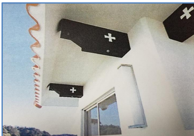
飾り梁全改修
